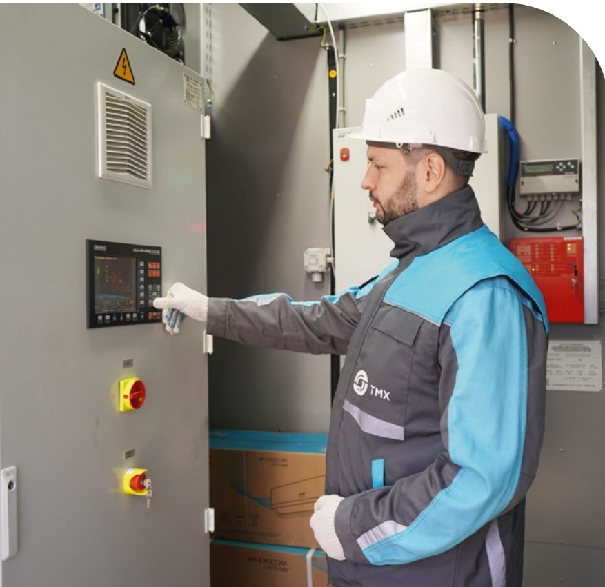
Управление работой станции выполняется с панели, расположенной внутри электротехнического отсека, или дистанционно с персонального компьютера
