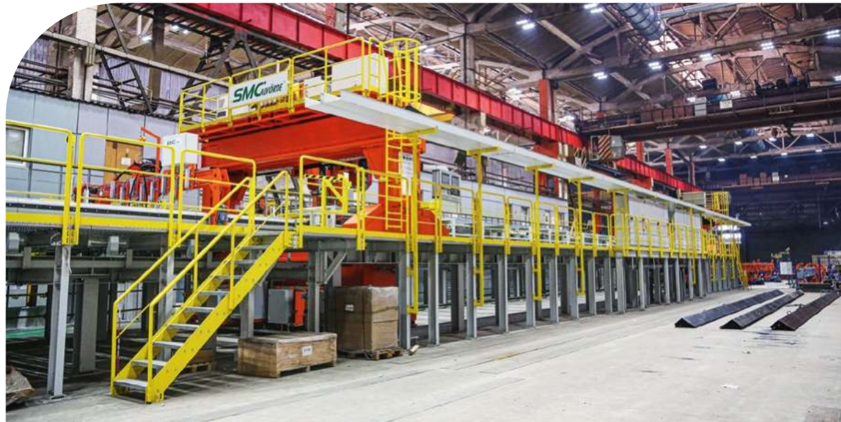
v Линия автоматической контактной сварки ТВЗ
