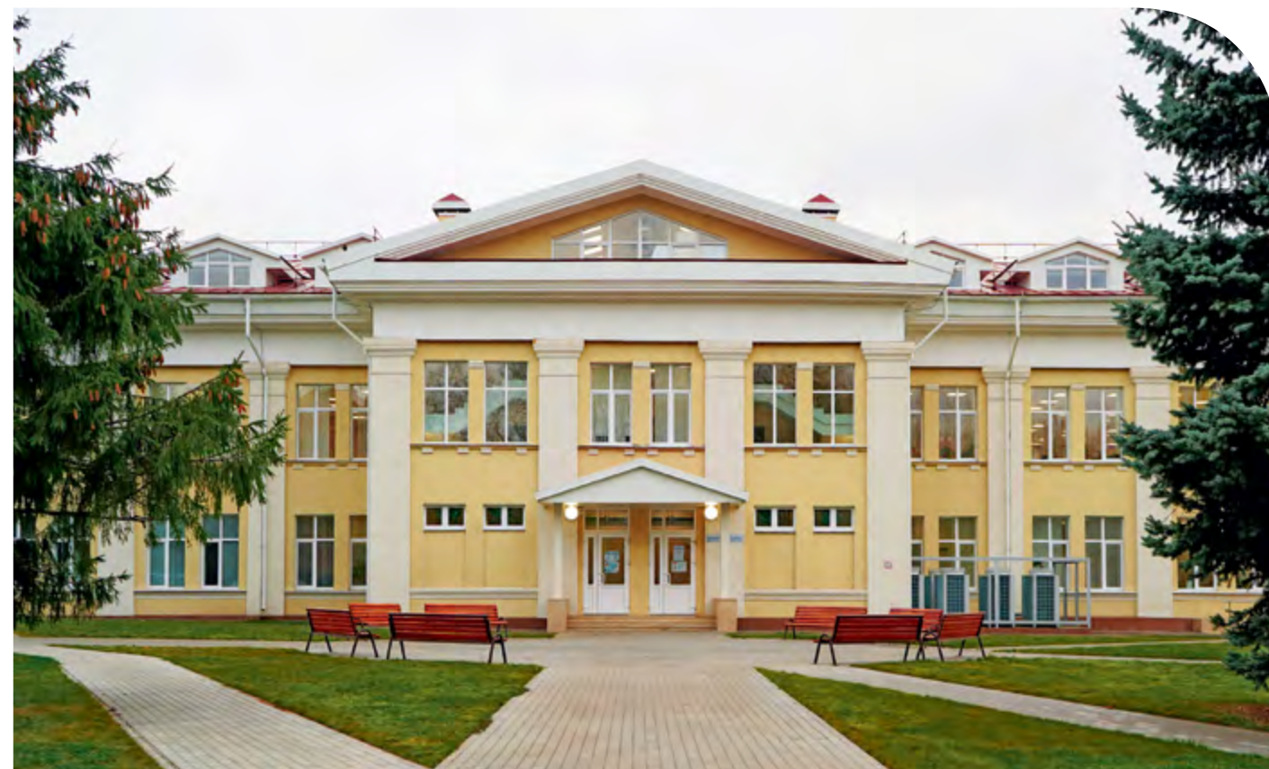
▲ Здание Инжинирингового центра двигателестроения ТМХ
